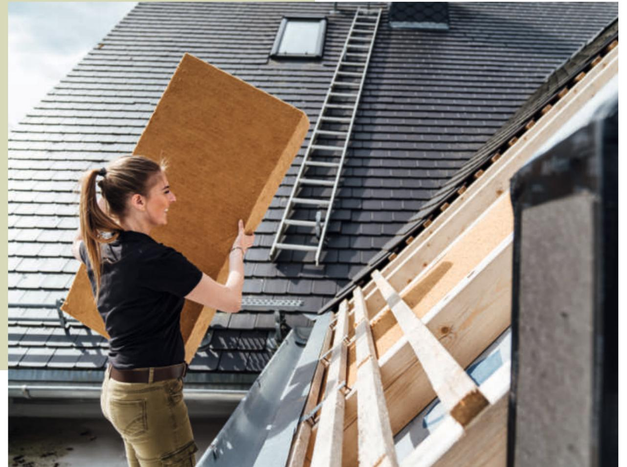
Von außen bringt man eine sogenannte **Aufsparrendämmung** an. Sie wird direkt unter den Dachziegeln angebracht, so dass keine Wärme nach außen entweichen kann. Das ist vor allem bei Neubauten sinnvoll oder wenn man Dach sowieso sanieren will.
